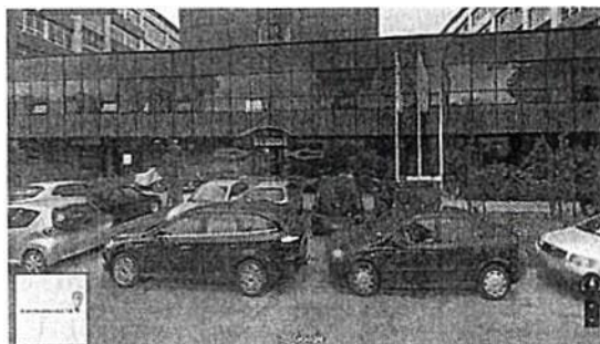
Rys.1 Wejście do budynku NFOŚiGW 1A przy ul. Konstruktorskiej
