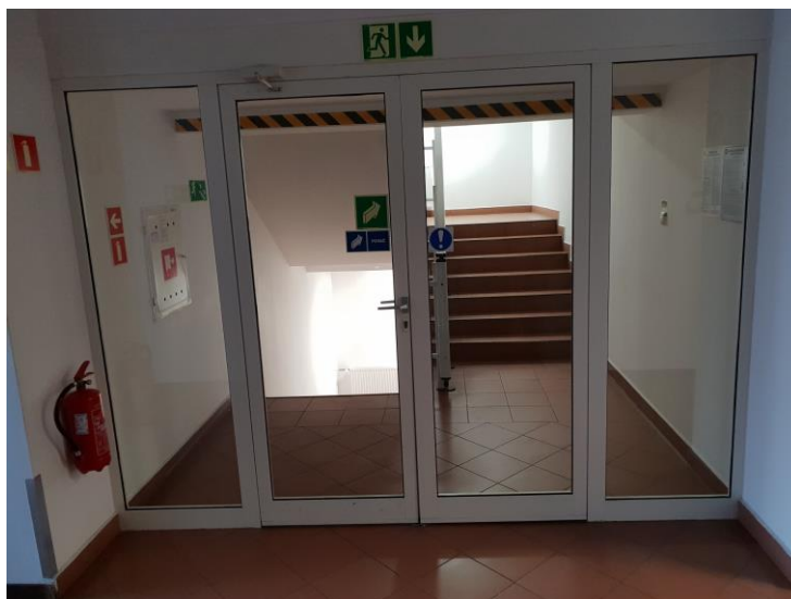
Foto. 3 Ścianka oddzielająca korytarz od dużej klatki schodowej wg stanu istniejącego (piętra II-V, wymiary: 3000x2480).
