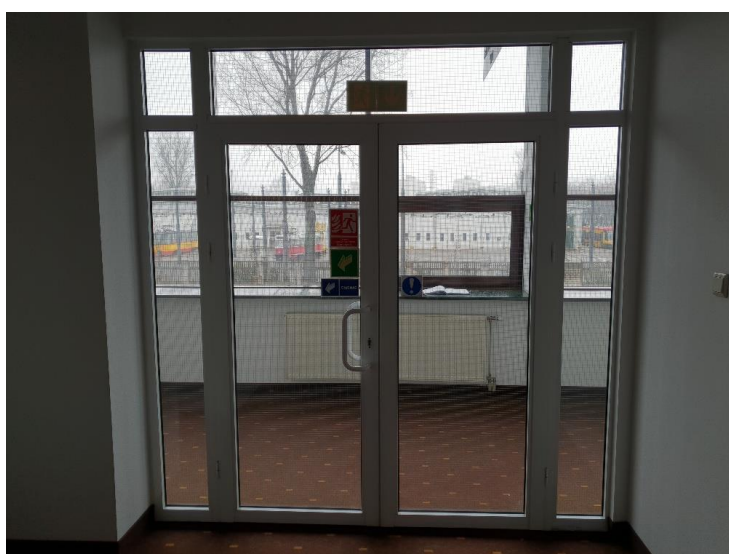
Foto. 6 Ścianka oddzielające korytarz łącznika od budynku 1A wg stanu istniejącego (piętro I, wymiary: 2450x2500).
