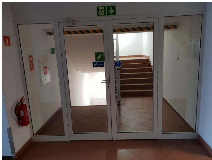
Foto. 3 Ścianka oddzielająca korytarz od dużej klatki schodowej wg stanu istniejącego (piętra II-V, wymiary: 3000x2480).
