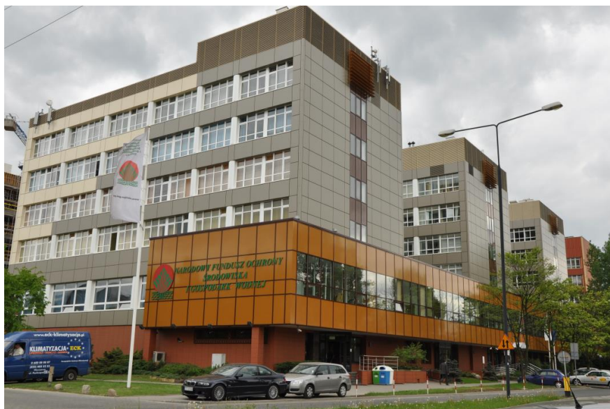
Rys. 1. Budynki Narodowego Funduszu Ochrony Środowiska i Gospodarki Wodnej
